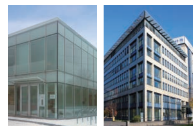
Fujitsu General (UK) Co., Ltd. (UK)
