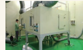
إختبار المسعر الحراري Calorimeter testing
