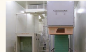
اختبار تنفق الهواء Airflow testing
