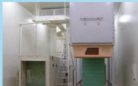
اختبار تدفق الهواء Airflow testing
