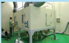
إختبار المسعر الحراري Calorimeter testing
