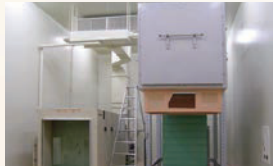
اختبار تدفق الهواء Airflow testing
